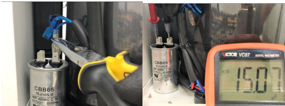
【左图：使用尖嘴钳将压缩机电容端子取出；右图：使用万用表电容档测量电容值】
