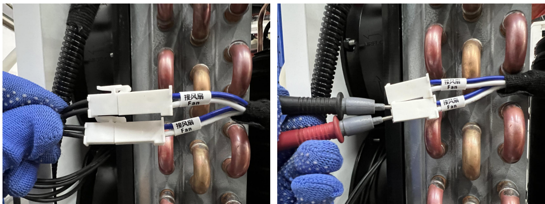
【左图：“接风扇”线束端子位置（2个）；右图：测量内阻】
